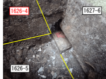
GPK04 既設コンクリート杭
